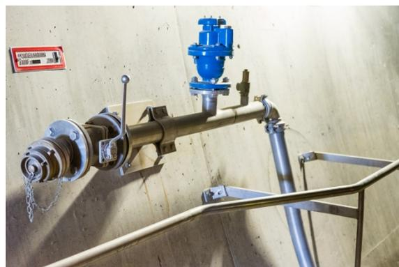
Abbildung 49: Schlauchanschlusseinrichtung
