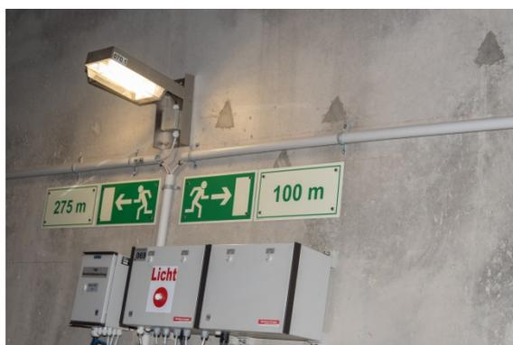
Abbildung 50: Fluchtwegkennzeichnung unter Notbeleuchtung
