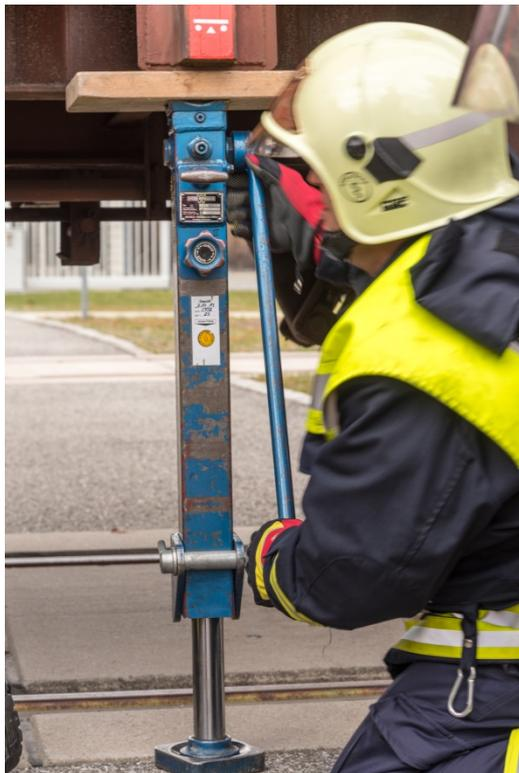
Abbildung 44: Anheben mittels Büffelheber
